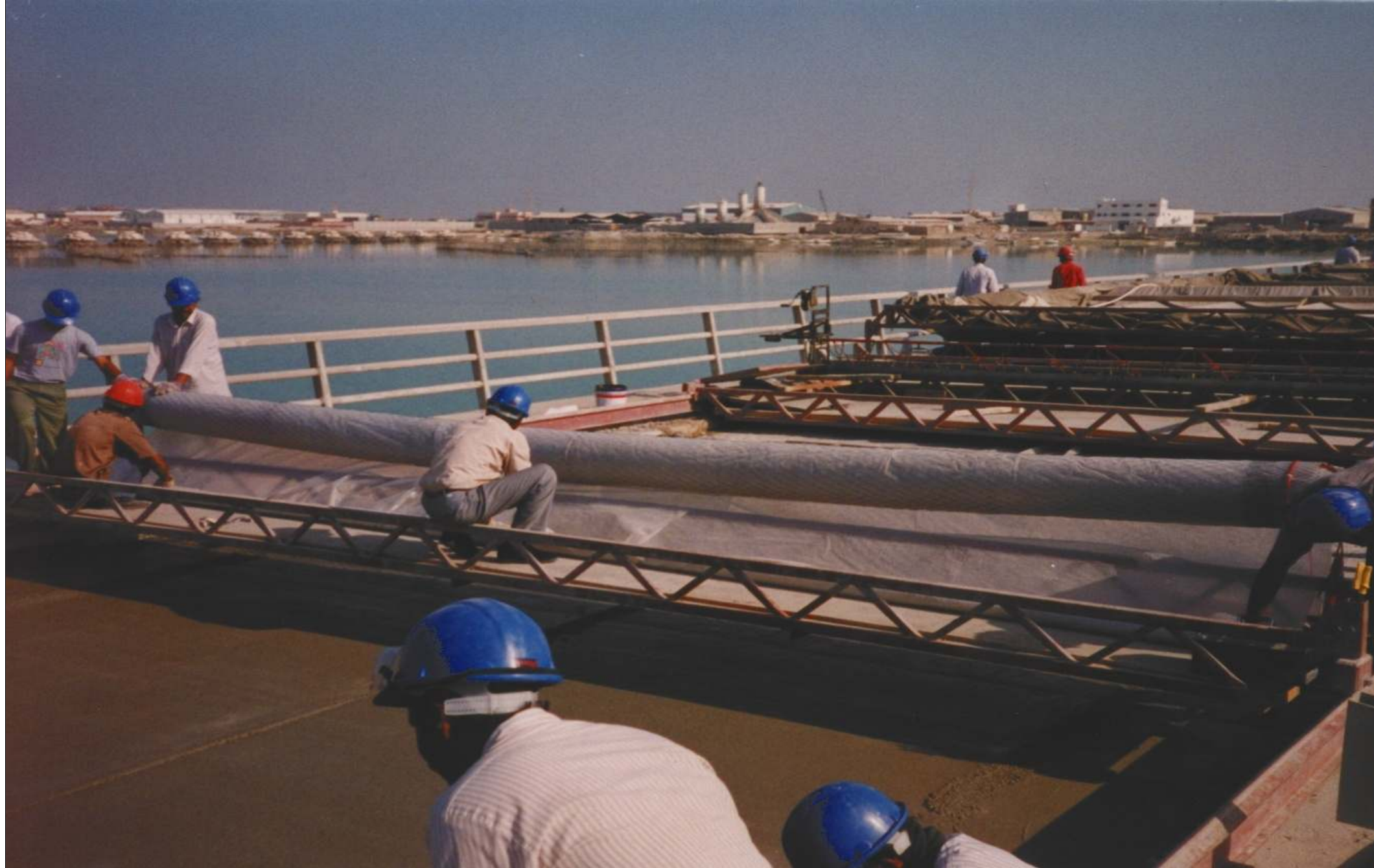
Instalacja anody siatkowej na ‘mokrym’ betonie Manama – Sitra (Bahrajn)
