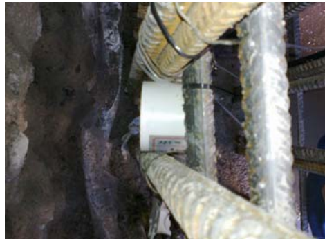
Fot. 7–8. Instalacja czujnika korozymetrycznego na zbrojeniu z ustawieniem w kierunku zewnętrznej warstwy betonu
