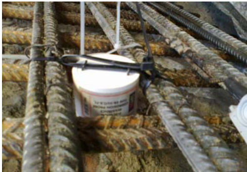
Fot. 7–8. Instalacja czujnika korozymetrycznego na zbrojeniu z ustawieniem w kierunku zewnętrznej warstwy betonu
