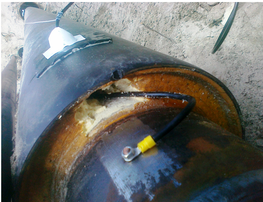
Rys. 6. Podłączenie przewodu pomiarowego do rury preizolowanej
