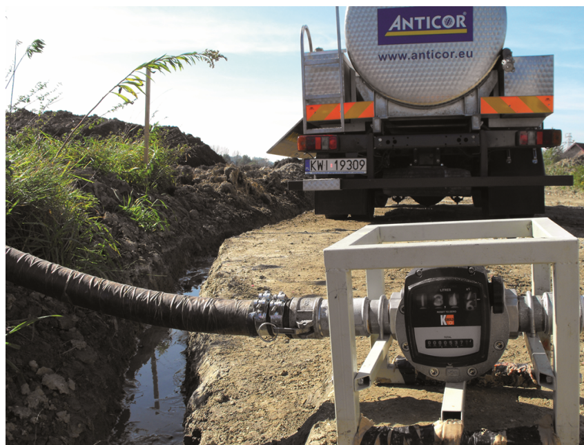
Rys. 2. Aplikacja masy izolacyjnej – zdjęcie licznika przepływu
