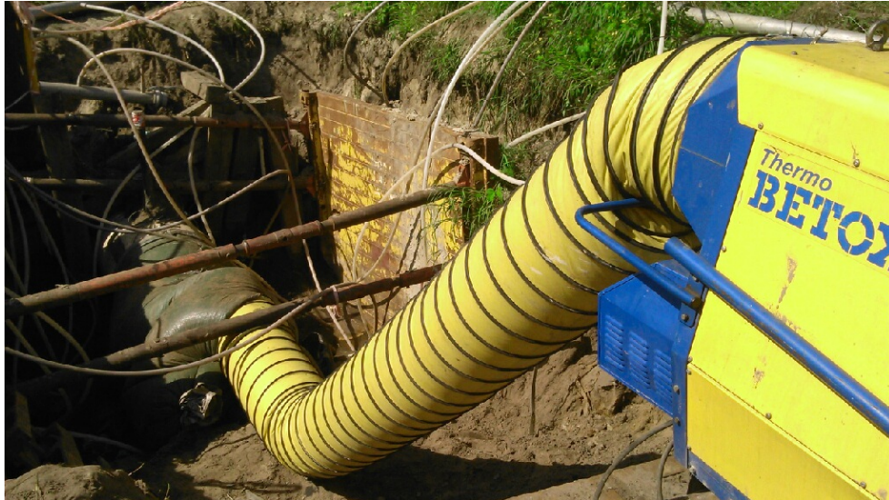
Rys. 4. Suszenie przestrzeni międzyrurowej przy użyciu nagrzewnicy przemysłowej
