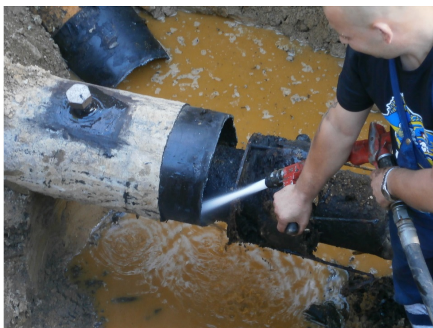
Rys. 3. Mycie przestrzeni między rurą przewodową, a ochronną wodą pod wysokim ciśnieniem
