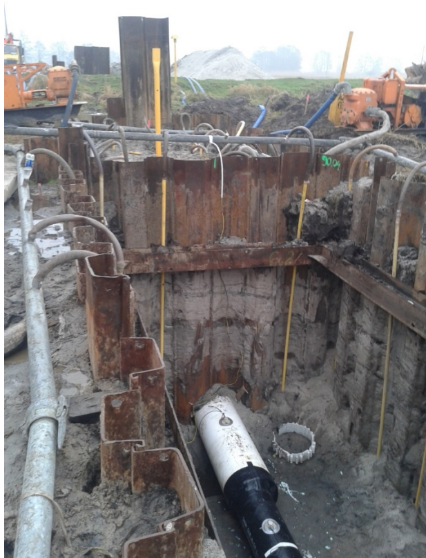
Rys. 1. Przekroczenie rzeki gazociąg DN700 w rurze osłonowej DN900
