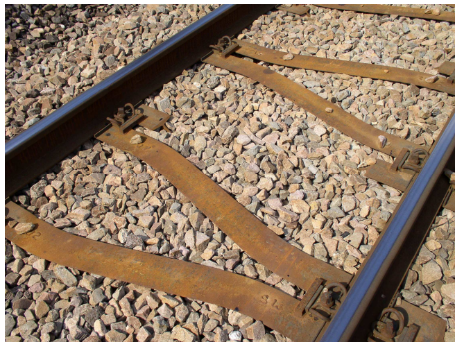
Rys. 2. Widok ogólny torowiska z podkładami stalowymi typu Y
