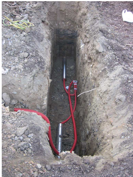
Obr. 4. Výkop jámy pro anody, hl.2,2m pod úrovní stávajícího terénu. Terén je v konečné podobě zvýšen o další cca 0,5 až 1m. Kabely jsou uloženy v chráničkách, svorkování je provedeno v krabici a chráněno silikonem
