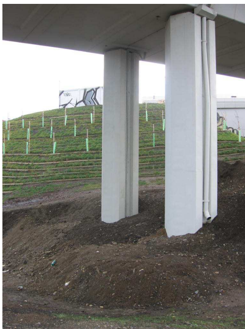
Obr. 5. Uložení kabelových vedení na pilíři. Kabely jsou uloženy v ocelových trubkách z důvodu ochrany před zloději. Vše je zakryto sanačním nátěrem (vedení jsou na zadním pilíři)
