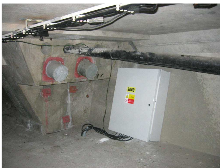
Obr. 6. Umístění rozvaděče katodické ochrany v tubusu mostu. Rozvaděč je vybaven zabezpečovacím kontaktem a bezpečnostním zámekem
