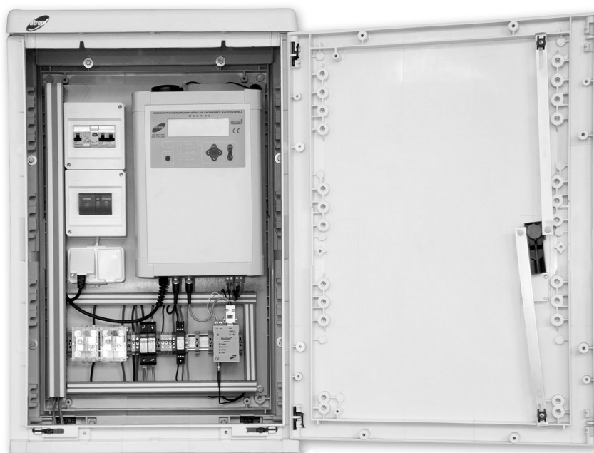
Rys. 2. Przykładowa instalacja Mikroprocesorowej Stacji Ochrony Katodowej MSOK-02
