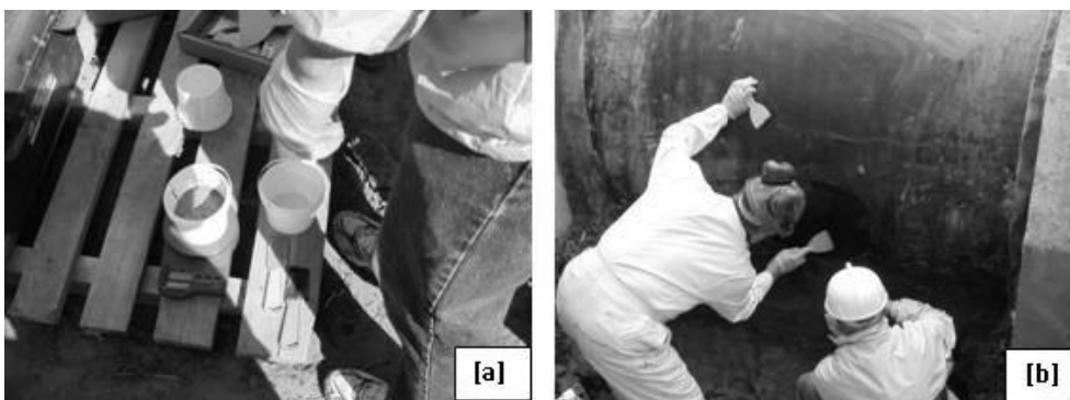
Rys. 5. Wykonanie naprawy materiałami ICAT LS 2001 CT
