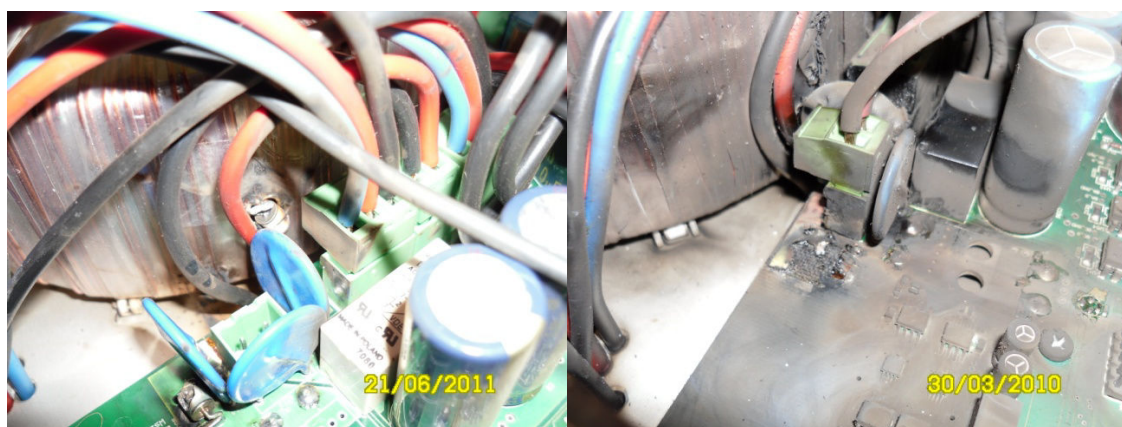
Rys. 4 Przykładowe zdjęcia uszkodzeń wewnętrznych urządzenia w wyniku wyładowań atmosferycznych (zdj. Atrem S.A.)
