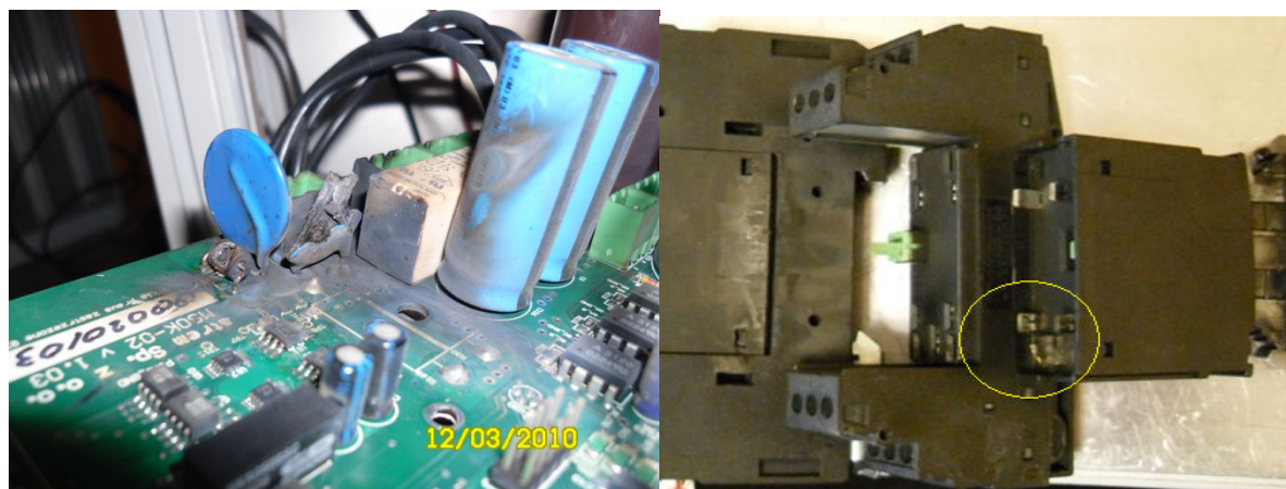
Rys. 5 Przykładowe zdjęcia uszkodzeń wewnętrznych urządzenia oraz zabezpieczeń zewnętrznych w wyniku wyładowań atmosferycznych (zdj. Atrem S.A.)
