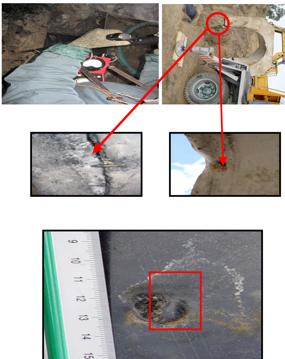
Rys. 3. Zlokalizowany i odsłonięty defekt izolacji gazociągu. Był on spowodowany przez wystający stalowy pręt zbrojenia obciążnika.
