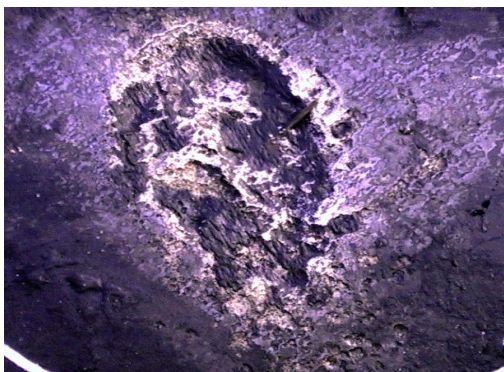
Rys. 5. Wżer w ścianie gazociągu
