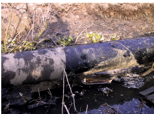
Rys. 4. Widok powłoki izolacyjnej
