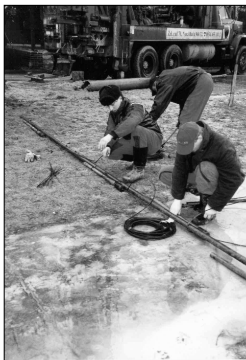
Montaż elementów FeSi głębokiego uziomu anodowego przed opuszczeniem w odwiert
