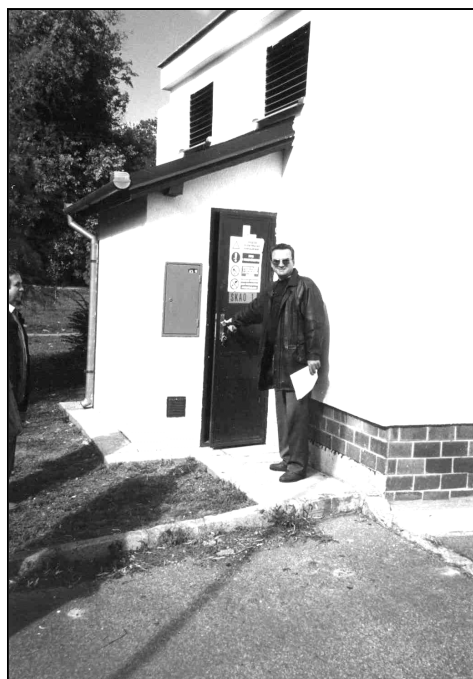
Pomieszczenie stacji ochrony katodowej jako dobudówka do stacji transformatorowej 23/0,4 kV
