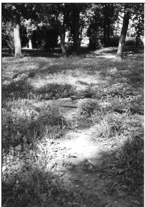
Widoczna część głębokiego uziomu anodowego w parku miejskim
