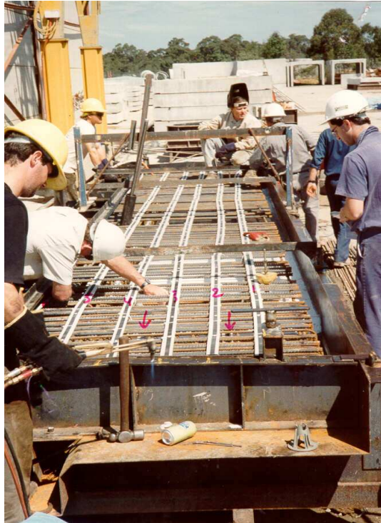
Rys. 8. Montaż tytanowych anod wstęgowych na zbrojenie betonu [4]
