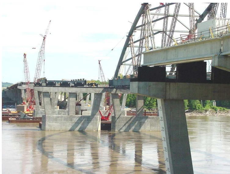
Rys. 6. Powłoka CIM nałożona na konstrukcje mostowe [3]
