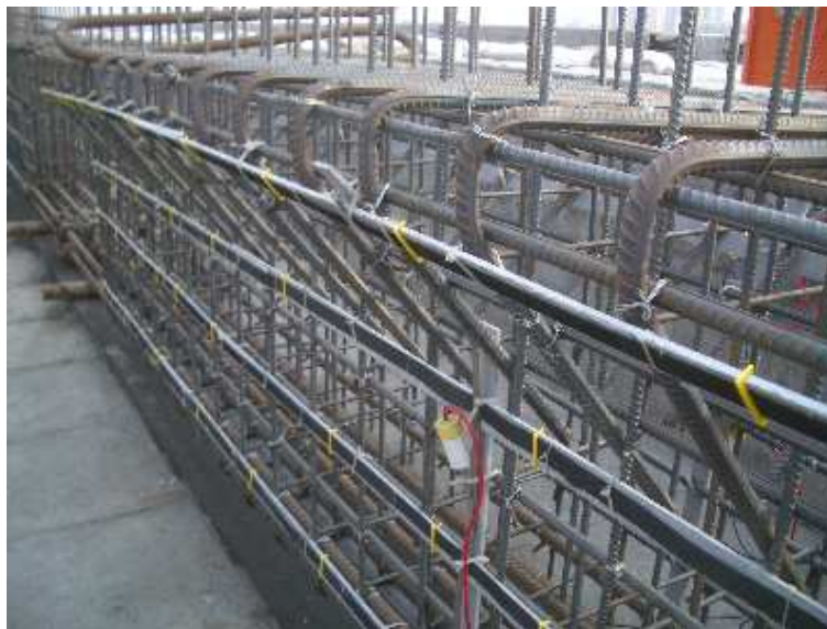
Rys. 9. Anody wstęgowe zamocowane na zbrojeniu betonu. Widoczna elektroda odniesienia [4]
