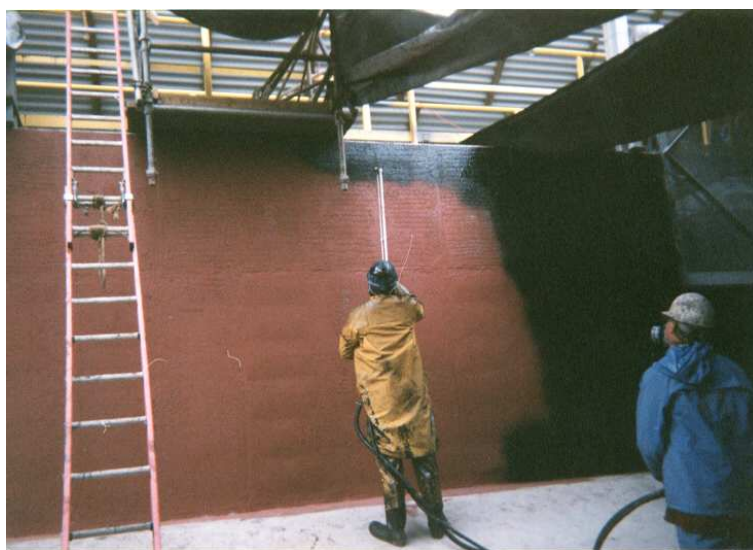
Rys. 7. Nakładanie CIM w basenie zbiorczym chłodni kominowej [3]
