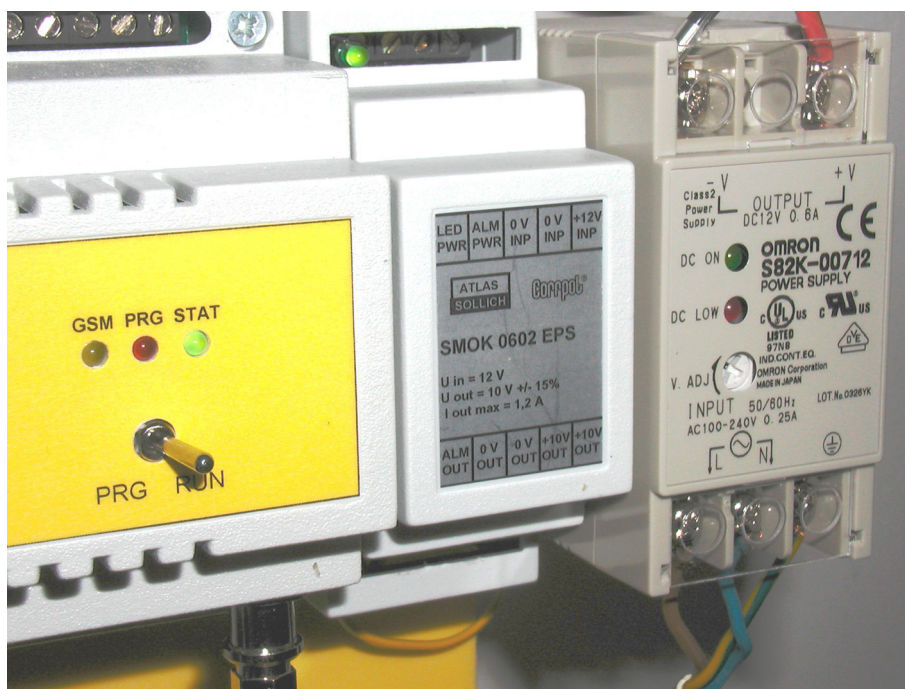
Fot.1.Podstawowa konfiguracja układu monitorującego stację ochrony katodowej (od lewej): sterownik z modułem GSM/GPRS, zasilacz buforowy i impulsowy zasilacz sieciowy.
